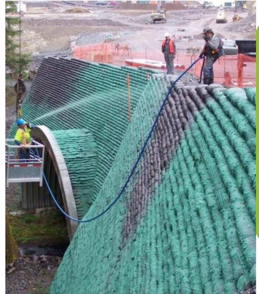
El Sistema Stratum-Eco es un método diseñado para mitigar la socavación en las laderas del cauce y evita el lavado de fino, dando estabilidad a los materiales que rodean las estructuras.
